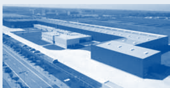
Hörmann Tianjin, Kína
