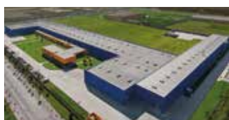
Hörmann Tianjin, Kína
