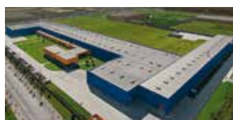
Hörmann Tianjin, Kína
