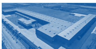
Hörmann Tianjin, Kína
