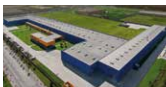
Hörmann Tianjin, Kína
