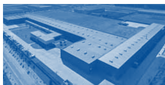
Hörmann Tianjin, Kína
